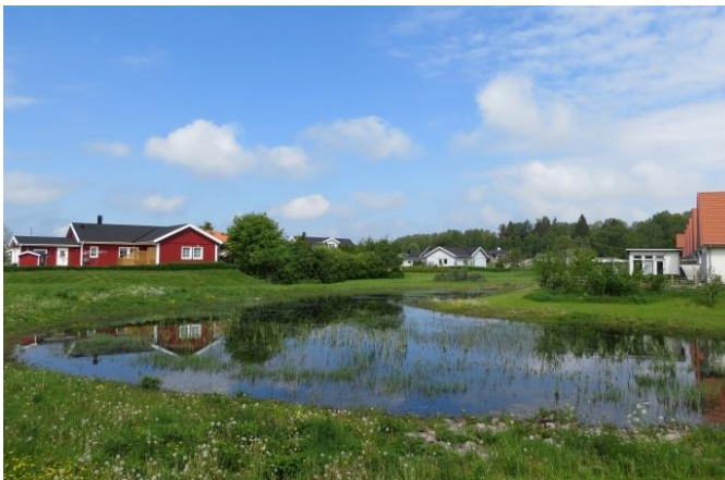
Figur 1. Fördröjningsyta för dagvatten.
