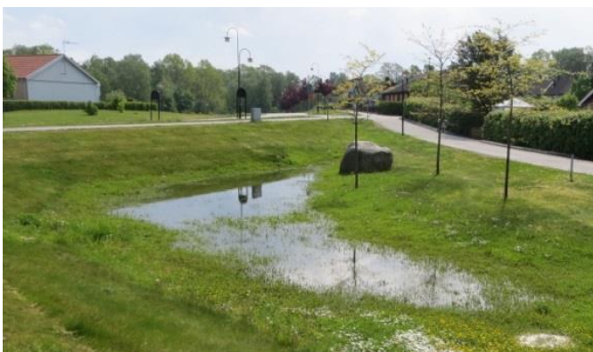
Figur 2. Fördröjningsyta för dagvatten.
