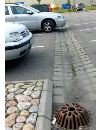
Figur 4. Med små diken vid bilarnas front kan dagvatten avledas ytligt.
