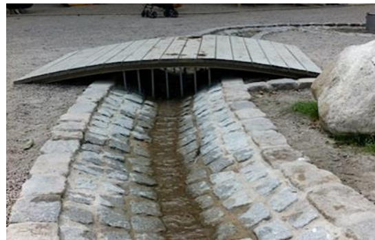
Figur 3. Med ett flackt dike kan dagvatten avledas ytligt. För tillgänglighet anläggs små bryggor.
