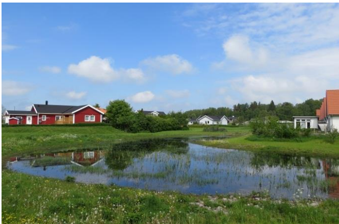
Figur 1. Fördröjningsyta för dagvatten
