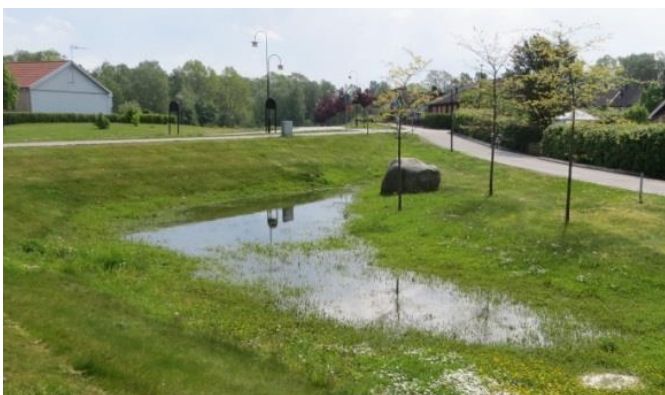
Figur 2. Fördröjningsyta för dagvatten
