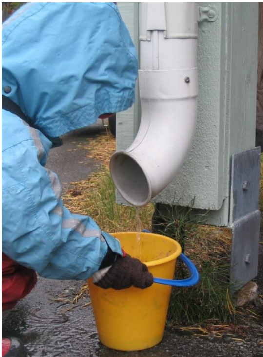
Figur4. Med hjälp av stuprörsutkastare kan dagvattnet omhändertas lokalt.
